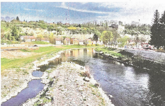
März 2014: Ein Jahr vor Gartenschau laufen an der Enz Renaturierungsmaßnahmen. Der Fluss ist frei zugänglich, allerdings werden Sträucher gepflanzt, ... FOTO: LEO
